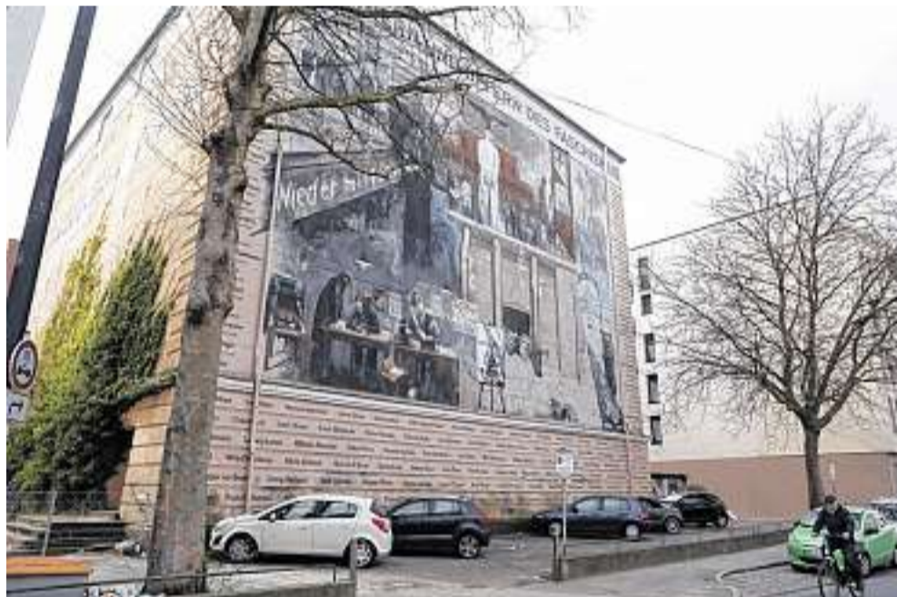
Der Bunker an der Admiralstraße 8 steht zum Verkauf. AVE
